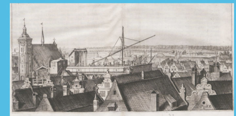
Obserwatorium Jana Heweliusza na dachach trzech kamienic w Gdańsku
